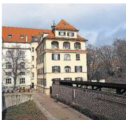
In diesem Gebäude wohnen derzeit noch elf Schwestern der Congregatio Jesu (Englische Fräulein).
